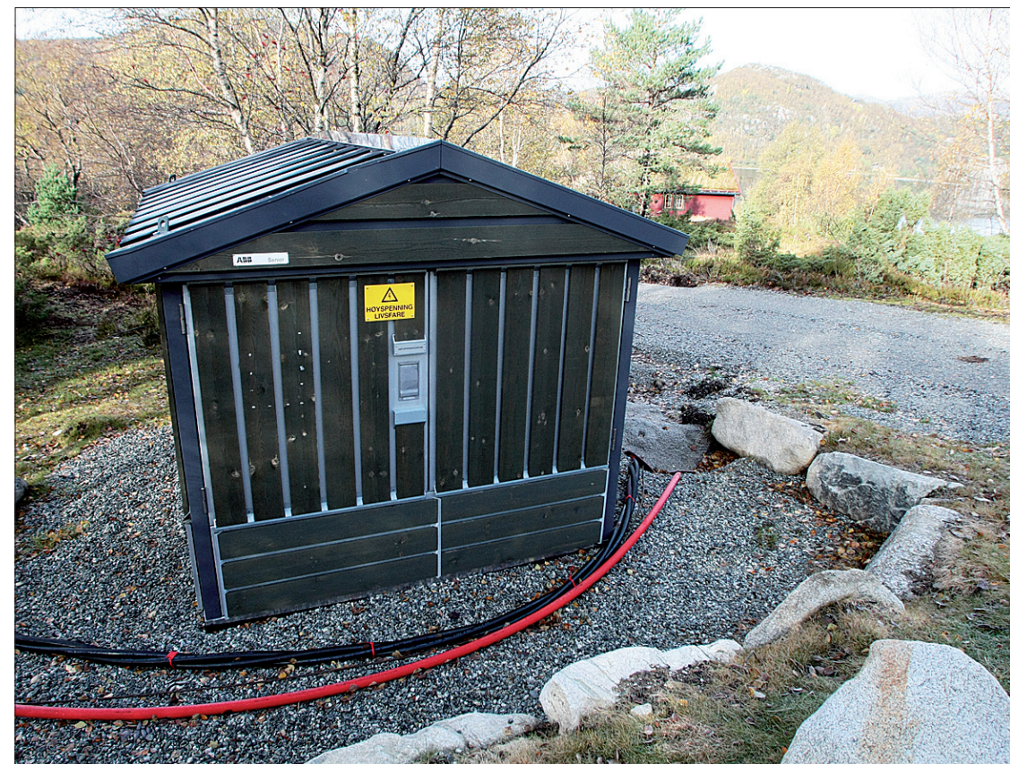
Strømboksen ved skitrekkekt skal gi strøm til alle hyttene.
